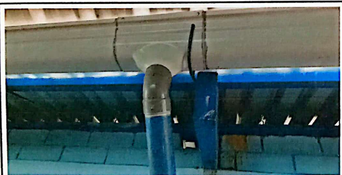
Foto 5: cambio de bajadas de agua
