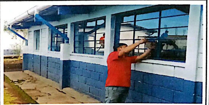
Foto 6: sustitución de ventanas
