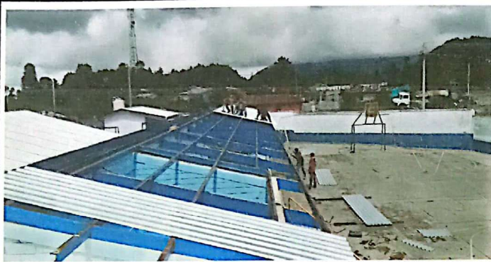
Foto1: sustitución de lámina
