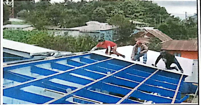
Foto 2: sustitución de lámina
