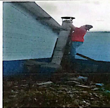
Foto 4: sustitución de chimenea
